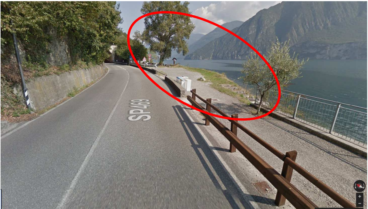
Piazzuola al termine della zona interessata dai lavori
